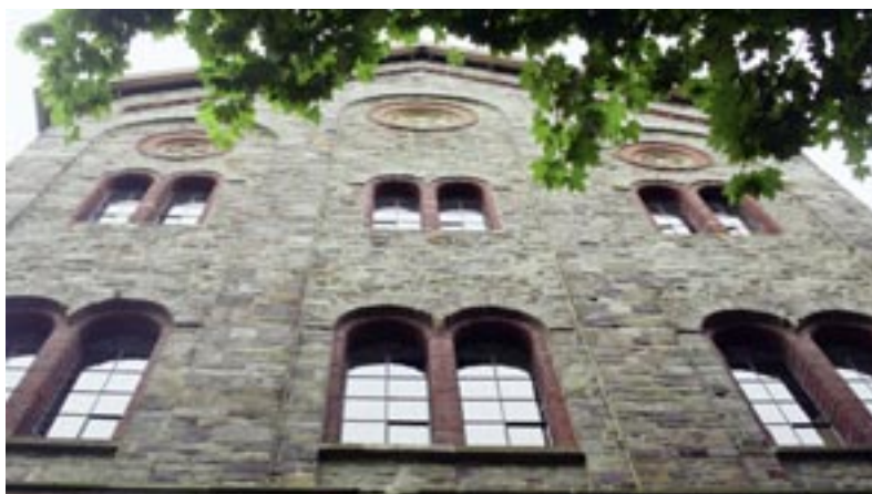
ARCHITEKTUR, die ins Auge fällt: Ein Teil der Nordfassade des Haseschachtgebäudes. Foto: Jürgen Krämer
