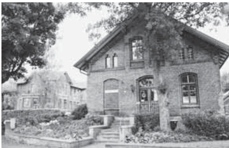
TYPISCH FÜR GEORGS-MARIENHÜTTE: Ein Gebäude, das aus so genanntem „Hüttenstein“ errichtet wurde. Foto: Jürgen Krämer
