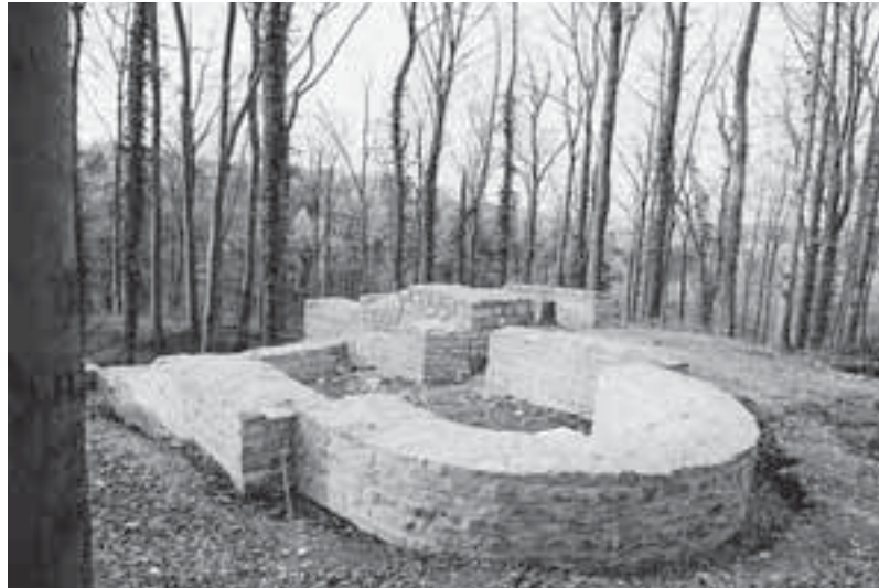
BLICK VON SÜDOSTEN auf die Kapelle und das dahinter liegende Tor der Burganlage. Zustand nach der Aufmauerung, Dezember 2009.
